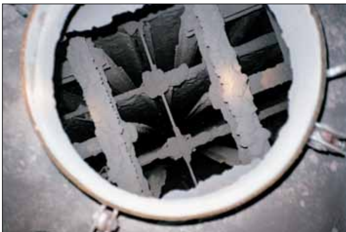
Después de seis semanas de producción sin Sonic Cleaning. Emisión de polvo: 29.4\text{mg}/\text{Sm}^3
