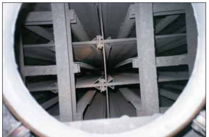
Después de seis semanas de producción con Sonic Cleaning. Emisión de polvo: 13.5\text{mg}/\text{Sm}^3
