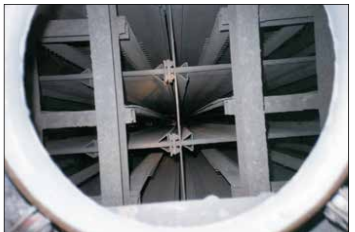
Nach sechs Wochen Produktion mit Schallreinigung. Staub-Emission 13.5\text{mg}/\text{Sm}^3
